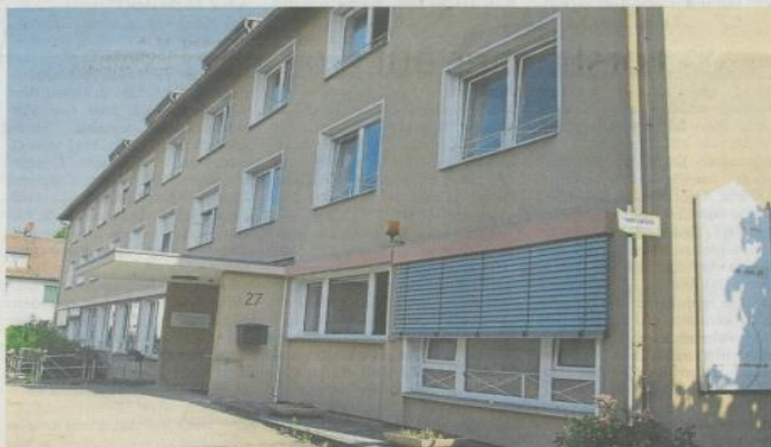
Das Hauptgebäude ist 55 Jahre alt. Dort ist man jetzt näher zusammengedrückt, damit der Komplex in der Friedensstraße abgerissen werden kann. Foto: Kirsten Weber
