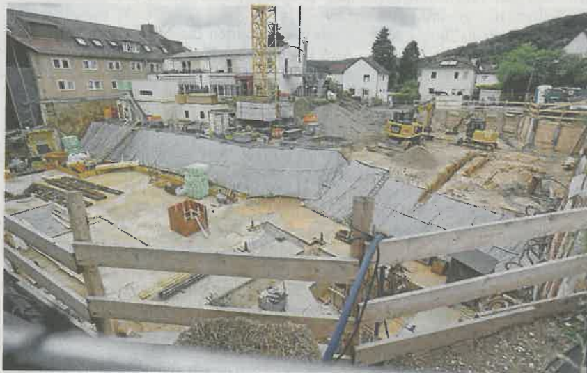
Sehr schwieriger Baugrund: Im Karree Staufenstraße; Friedenstraße, Lindenstraße entsteht das neue Martha-Else-Haus. Foto: Knapp
